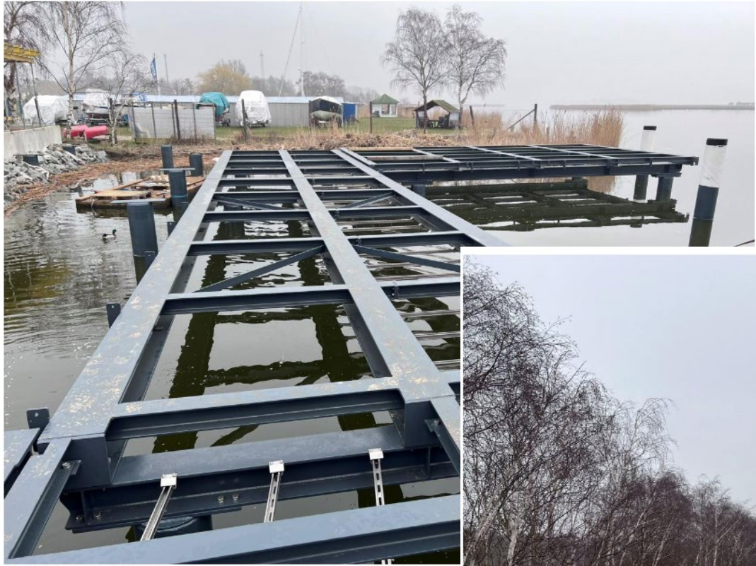
Bild 3: Montage Plattform Kanuanleger
