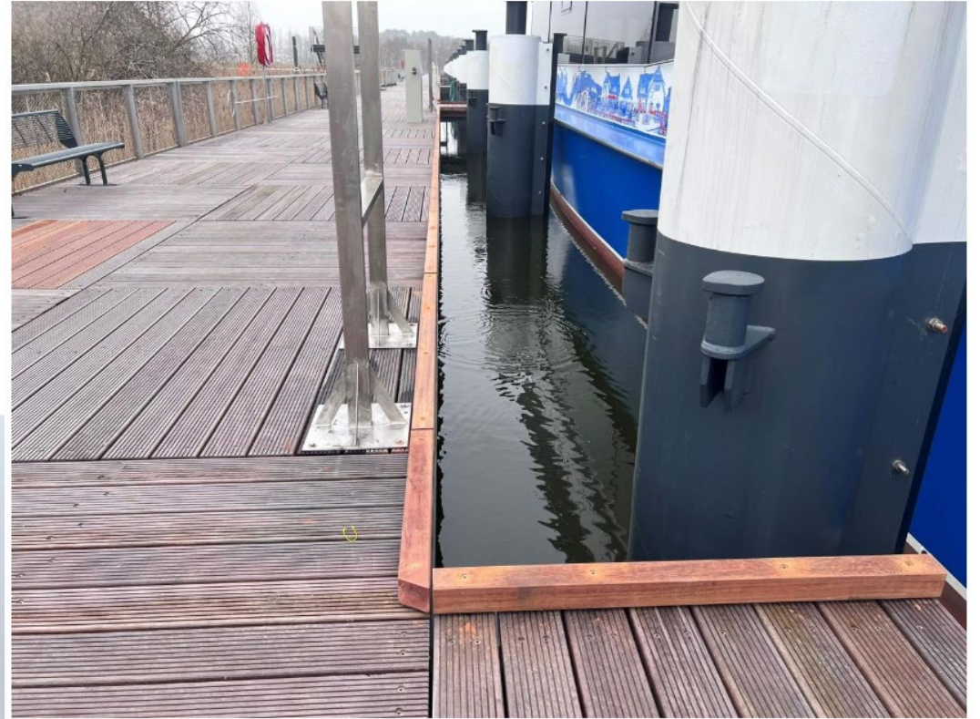
Bild 4: Montage Schrammborde Fahrgastschiffanleger
